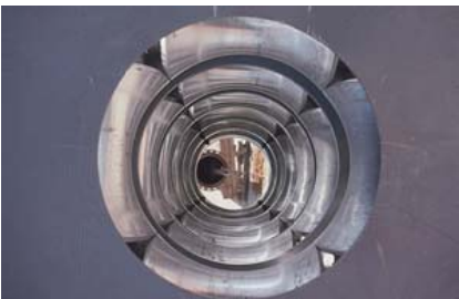
El sistema de rodillos permite reducir el encamisado en fases de manera que el mismo se reduce, permitiendo su instalación a pesar de ser de mayor diámetro que el interior del ducto de acero.
