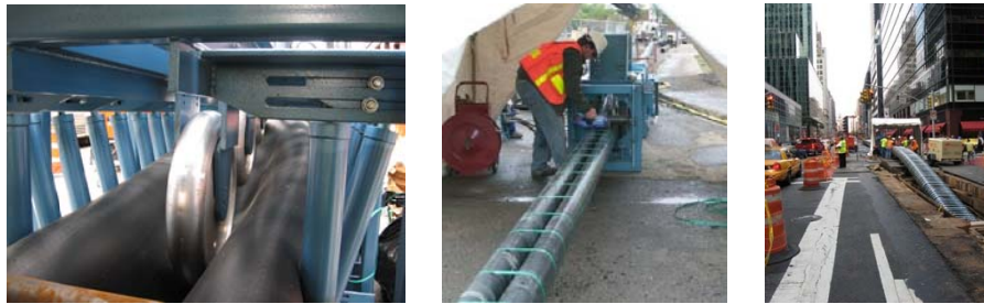
Diversas imágenes mostrando el doblado del encamisado termoplástico en forma de "U" así como su fijación con cintillos diseñados para reventar una vez presurizado el encamisado, así como imágenes del sistema Tite Liner siendo instalado en entornos urbanos complejos como la ciudad de Manhattan en Nueva York.
