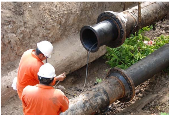
Instalación de empates bridados de sistema Tite Liner para sistema de manejo de agua congénita de 16" para el Activo Integral Samaria de Pemex Exploración y Producción – Región Sur.
