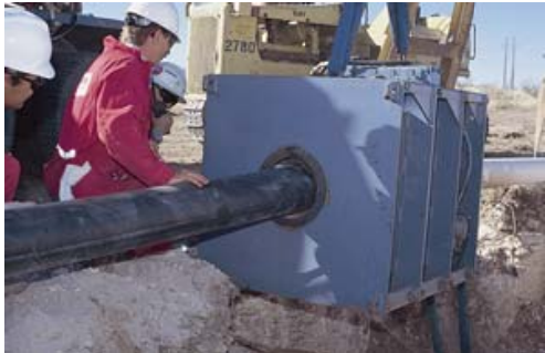
El sistema de rodillos se controla por medio de un sistema de poder hidráulico el cual permite una instalación rápida, segura y eficiente. Las lingadas del sistema Tite-Liner son generalmente instaladas en cuestión de minutos.
