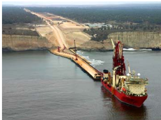
Instalación de sistema Tite Liner en línea marina a cargo de Technip de 12" en Cabinda, Angola, África.
