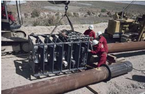
El sistema de rodillos se controla por medio de un sistema de poder hidráulico el cual permite una instalación rápida, segura y eficiente. Las lingadas del sistema Tite-Liner son generalmente instaladas en cuestión de minutos.
