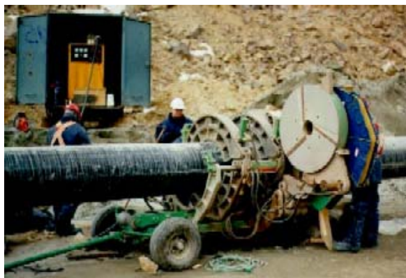
La termofusión del sistema Tite-Liner utiliza un proceso en el cual los tramos de tubería termoplástica se unen por fusión formando una camisa resistente y homogénea.
